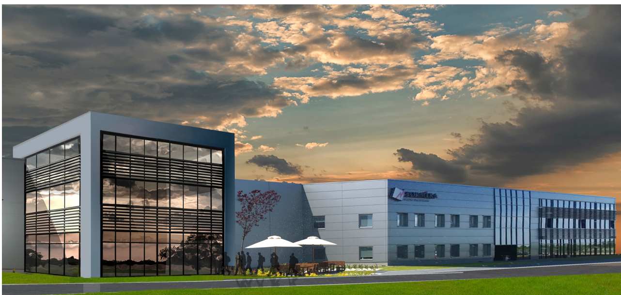
Kompleksowa rozbudowa drukarni fleksograficznej w Parzniewie w gminie Brwinów
